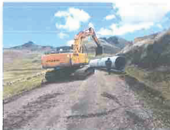
Armado y colocación de alcantarillas - VIA CHUQUIBANTZA-LÍMITE PROVINCIAL CON BOLÍVAR
